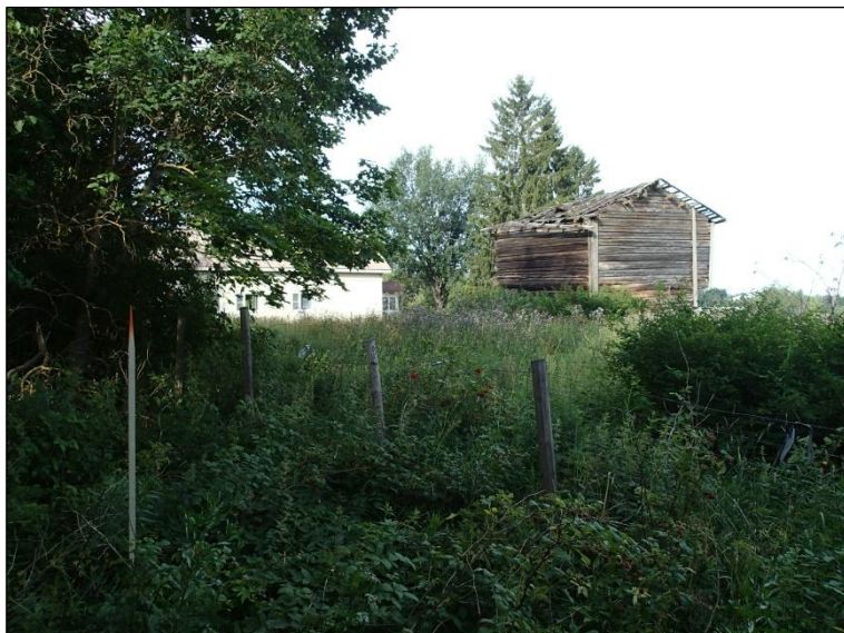
Maakaapelilinjaa Juppalan alueella. Taustalla vanha riihi.
