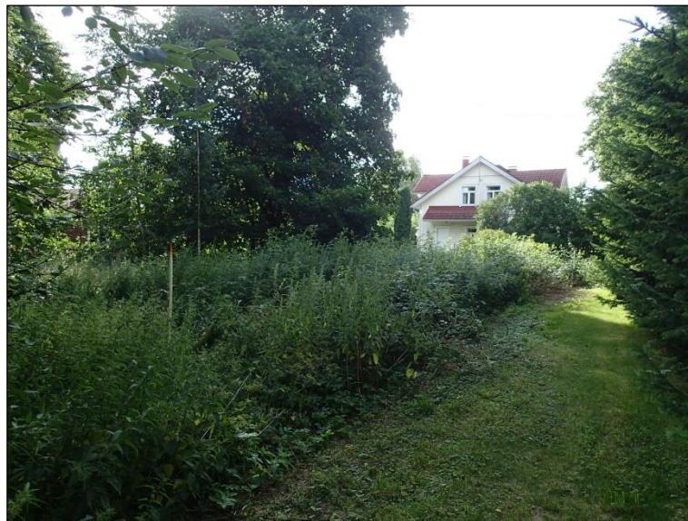
Maakaapelilinjaa Juppalan alueella.
